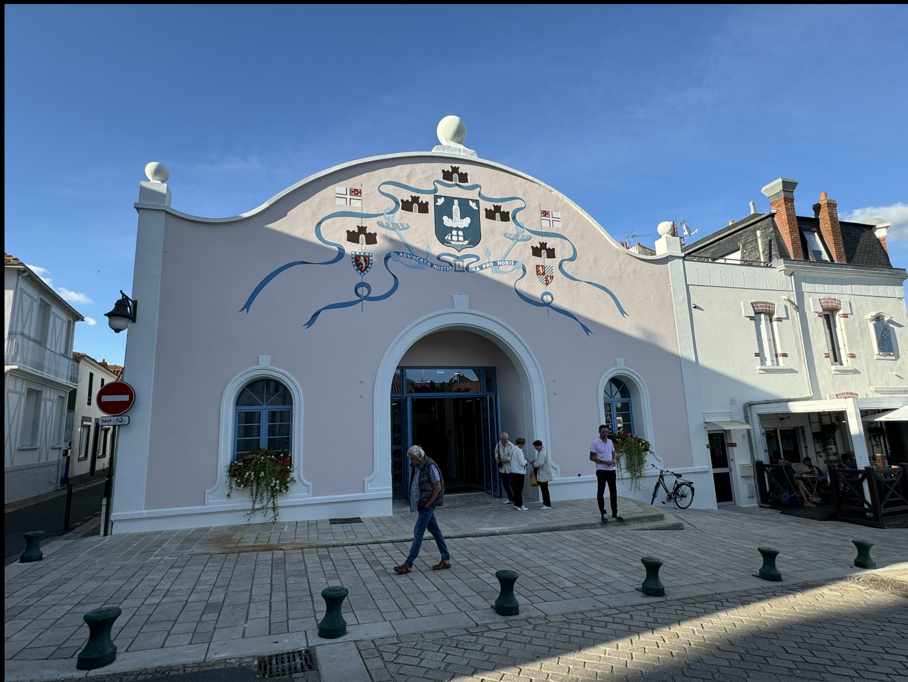
Rénovation de la salle des fêtes de la Chaume - Les Sables d'Olonne
